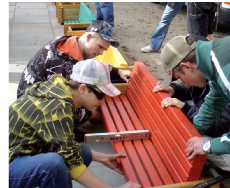
Die Vermittlung fachlicher Kompetenzen erfolgt über Sanierungsarbeiten an öffentlichen Anlagen in Halle-Neustadt.
